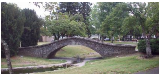
JUILLIARD PARK BRIDGE
